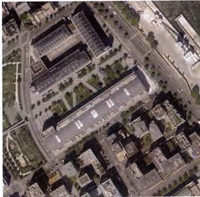
Vue aérienne de l'ancienne halle aux farines, Paris. Source : geoportail.gouv.fr
